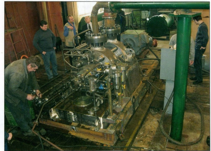
Рис. 7. Насосный агрегат АНДМс 350-600 на испытательном стенде
