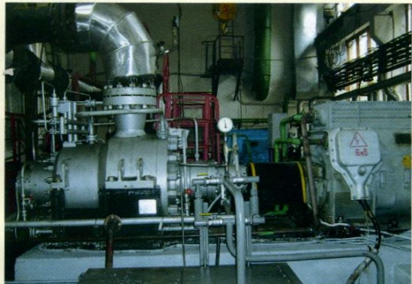
Рис. 4. Насосный агрегат АНДМг 600-320 (зав. № 3) в работе
